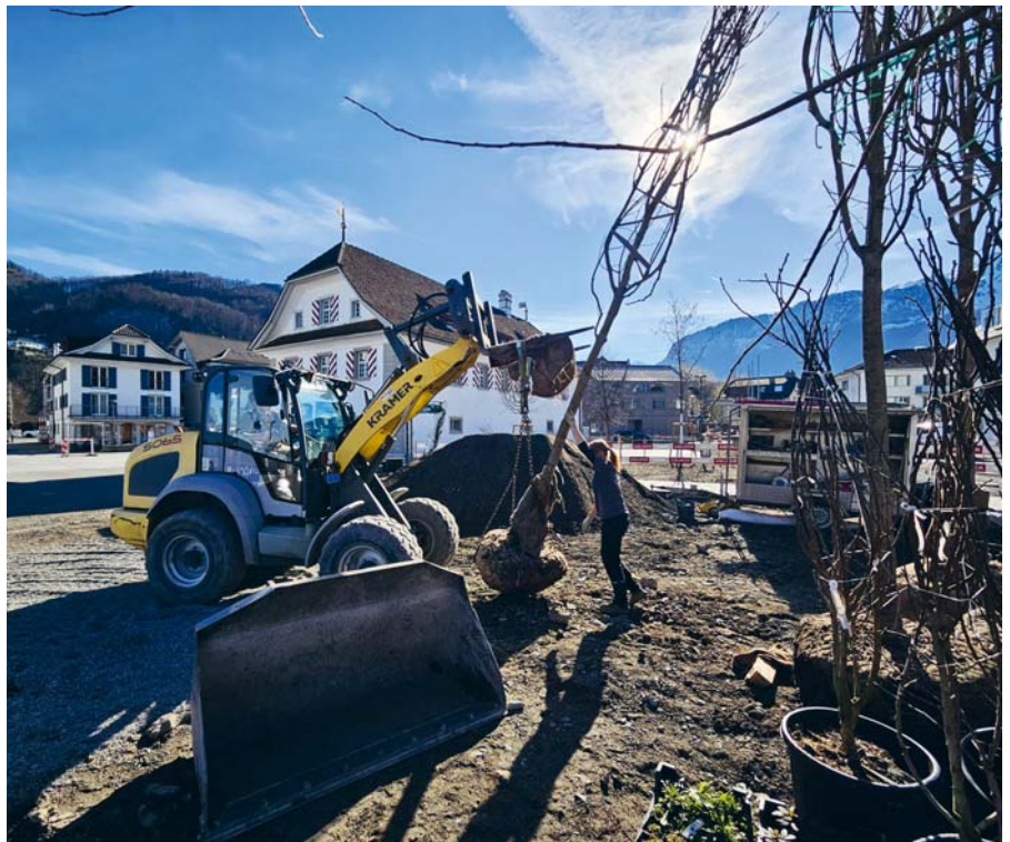
Noch vor wenigen Wochen liefen die Umgebungsarbeiten im Stansstader Dorfzentrum auf Hochtouren. Unter anderem wurden auf dem ganzen Areal zahlreiche neue Bäume gepflanzt. Bild rgi
