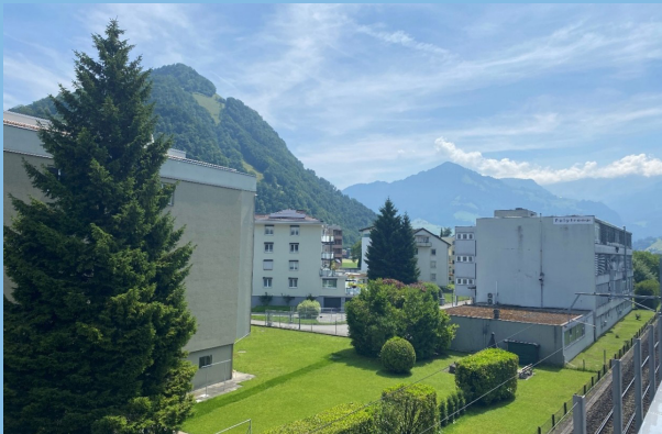
Abb. 10 Im Ausserfeld-Quartier besteht Verdichtungspotential.
