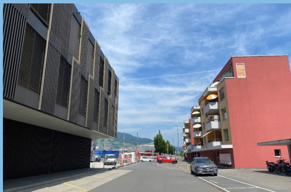
Abb. 8 Bahnhofsstrasse Stansstad: Links das Bürogebäude der Zentralbahn, rechts die Alterswohnungen der Riedsunnä, im Hintergrund entsteht das Neubauprojekt der Zentralbahn.
