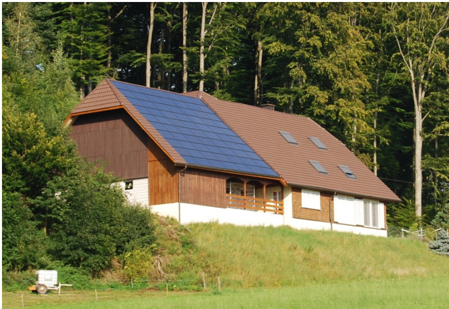
Abbildung 7 Dachintegrierte PV-Anlage (105 m 2 Modulfläche, 14 kW p Leistung).
