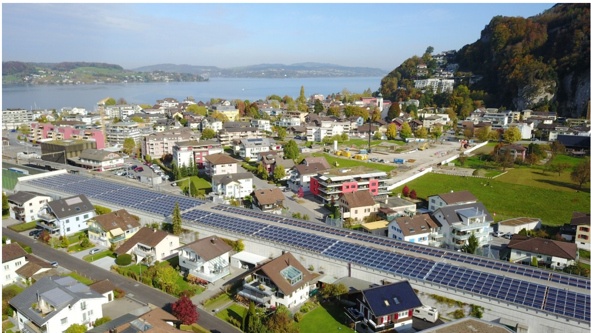
Bild: Solar Agentur Schweiz, Schweizer Solarpreis 2018, A2-Autobahnüberdachung
