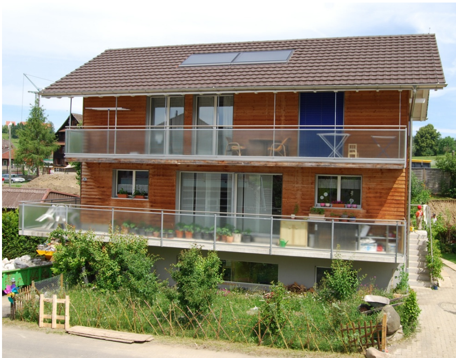
Abbildung 8 Dachintegrierte thermische Solaranlage (5 m 2 Kollektorfläche).
