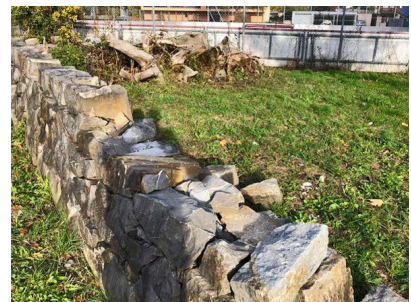
Auch Sachbeschädigungen müssen dann und wann verzeichnet werden. Hier wurde zum Beispiel die Trockenmauer beim Schulareal teilweise umgeworfen.
