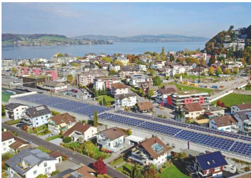
Seit Jahren setzt sich Stansstad für eine sinnvolle Energienutzung auf dem Gemeindegebiet ein, hier die Solaranlage auf der Autobahn. Bild Solar Agentur Schweiz, Schweizer Solarpreis 2018
