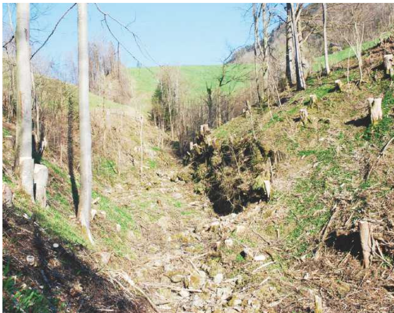
Ein Abschnitt im Giesslibach (dieser sorgte vor wenigen Jahren in Stansstad für massive Verwüstungen) nach erfolgtem Eingriff. Die instabilen Bäume im Bacheinhang wurden gefällt und mit dem Seilkran abtransportiert. Bilder zvg
