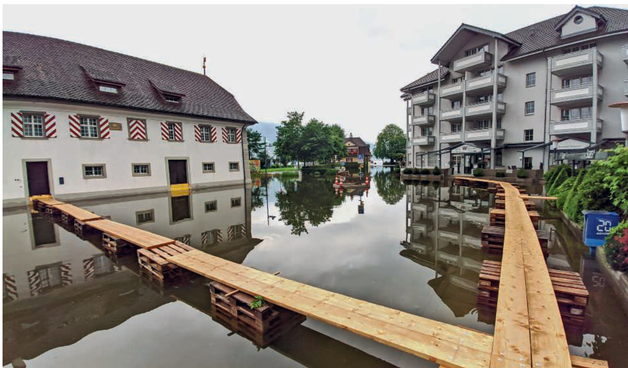
Die Sommerhochwasser haben gemäss NSV in Stansstad Schäden von rund zwei Millionen Franken verursacht. Bild zvg
