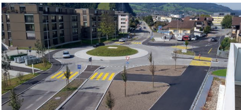
Im Frühjahr wird beim Kreisel Schürmatt der Deckbelag eingebaut. Bild zvg
