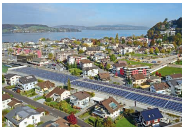
Mit einem kantonalen Förderprogramm möchte der Kanton Photovoltaik-Anlagen fördern. Im Bild die grosse Anlage auf der A2-Überdachung. Bild BE Netz AG
