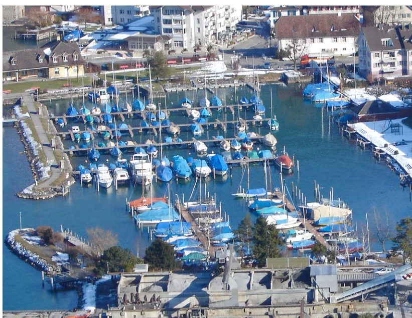
Die 1965 erstellte Stansstader Hafenanlage ist in die Jahre gekommen. Nun soll sie umfassend saniert werden. Bild zvg
