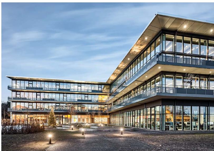
Eines der Referenzprojekte der W&P Engineering AG: der Neubau der Firma Opacc in Rothenburg. Bilder zvg
