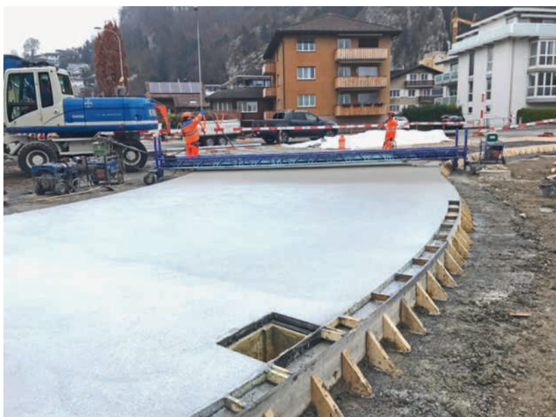
Die Strasse über den Mühlebach wurde um einen Meter verbreitert und im November wurde das erste Kreiselsegment betoniert (unten). Bilder zvg
